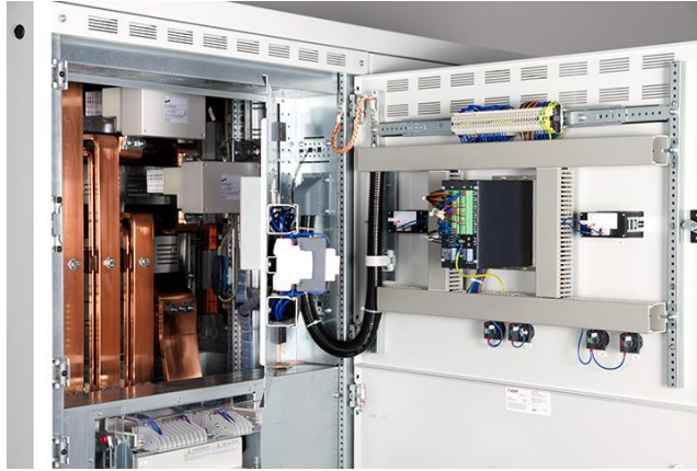
Imagem 3. O supressor de arcos elétricos DEHNshort®
