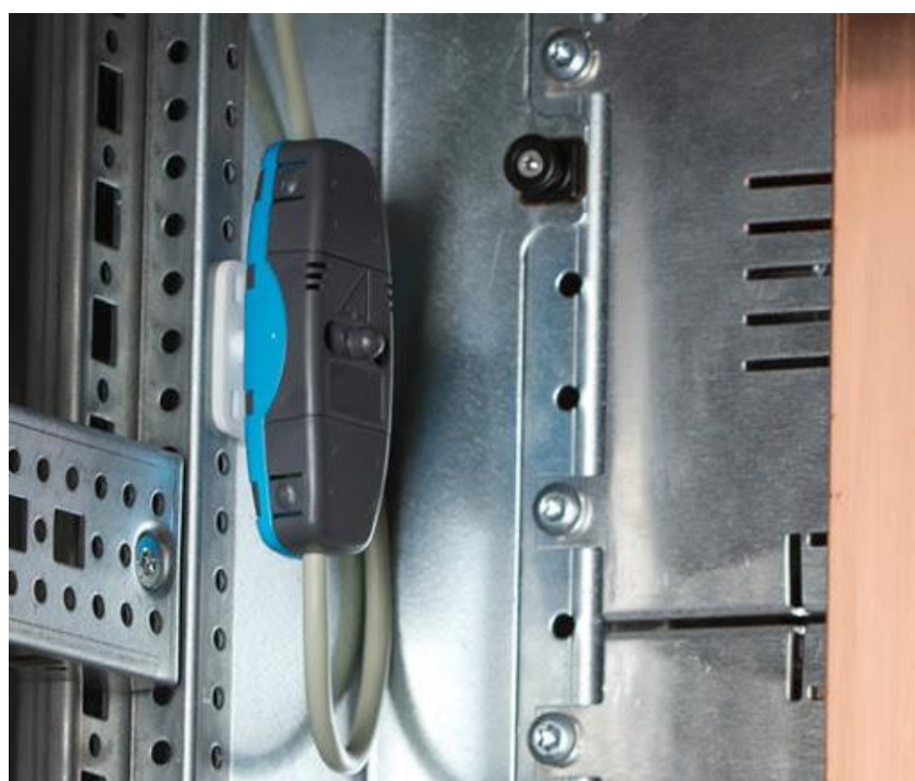
Imagem 2. Sensor pontual DEHNshort®. A maneira mais eficaz de detectar um arco elétrico.
