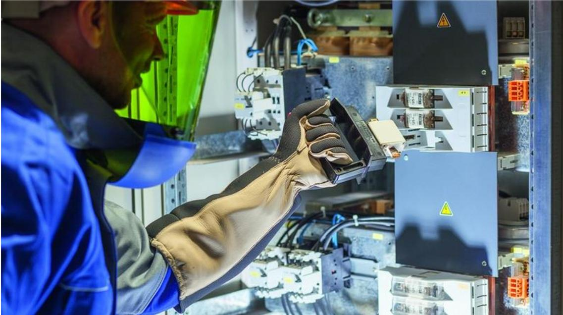
**Imagem 2. Luva de proteção contra arcos elétricos da DEHN.**
