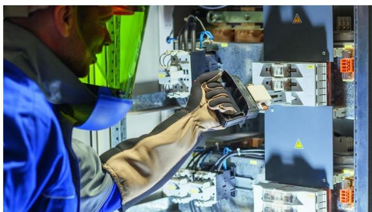
**Imagem 3. Luvas especiais para reduzir os efeitos de um arco elétrico em nossas mãos.**
