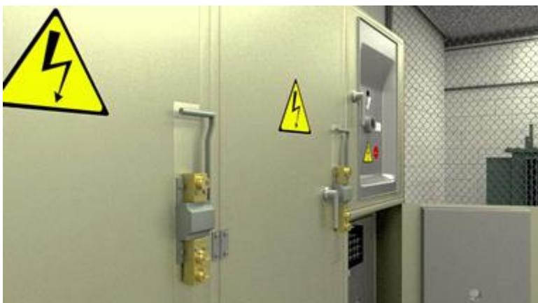
**Imagem 2. Sistemas de intertravamento impedem a abertura de painéis que não estejam desenergizados.**
