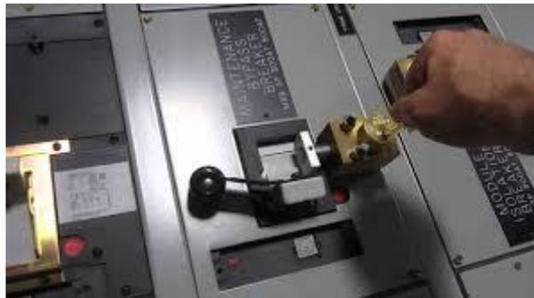
**Os sistemas de intertravamento implantados pela Lambda impedem que máquinas e equipamentos sejam acionados de forma equivocada.**
