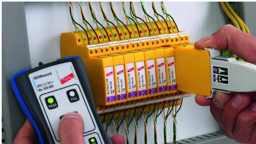
**Imagem 1. DPSs DEHN+SÖHNE, utilizados pela Lambda para a proteção contra surtos nas linhas de sinal.**
