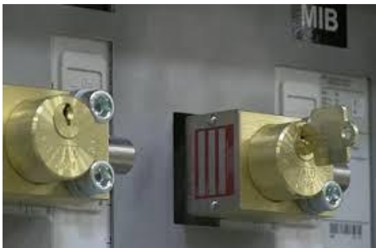
Imagem 2. Sistema de intertravamento Kirk Key Interlock™
