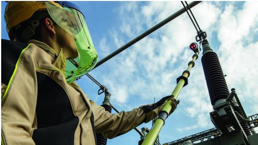
**Os detectores de tensão PHE4 podem ser expandidos facilmente.**
