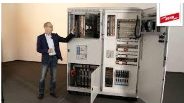
**Imagem 2. O DEHNshort<sup>1</sup> é um equipamento de proteção coletiva que interrompe o arco elétrico antes que ele alcance seu máximo potencial destrutivo.**
