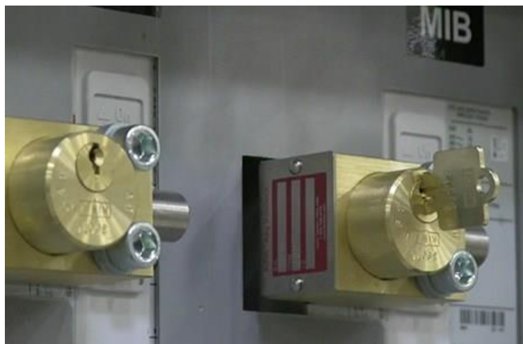
Imagem 2. Sistemas de intertravamento para evitar ações indevidas 1
