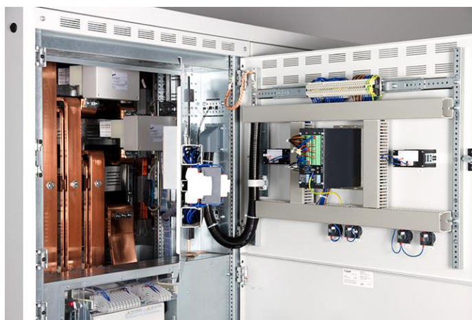
Imagem 3. Sistema de proteção contra o arco elétrico DEHNshort® 2
