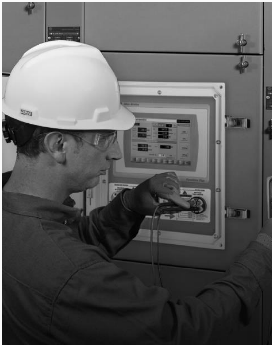
Figura 4. Trabalhador acessando o interior do painel através de uma GracePort®
